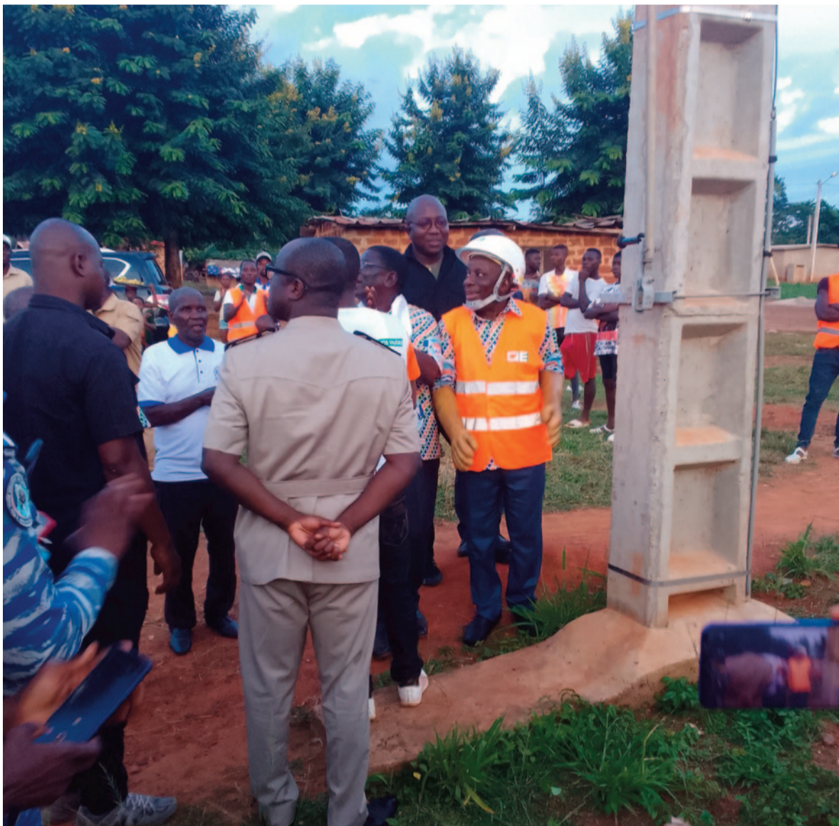
Des villages ont été électrifiés
